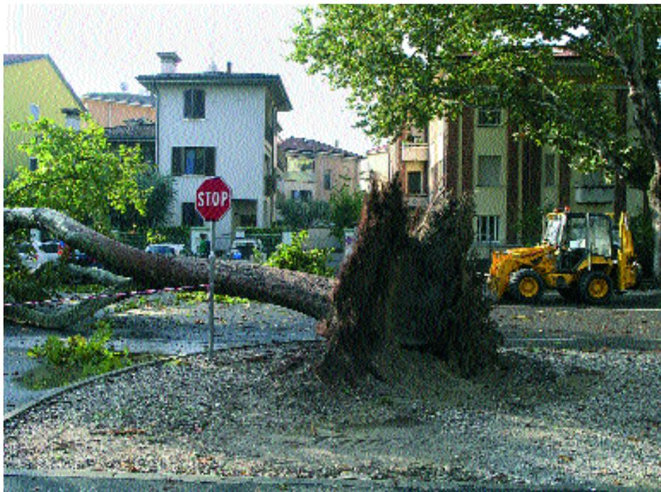
**Foto 8 - Schianto di pianta in ambiente urbano a causa di danni da scavo per posa sottoservizi**
